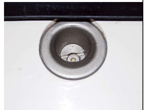
Onderdorpel: nastelbare sluitpot Ø 30 mm
