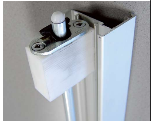
Onderkant deur: grendel met geleideblokjes
